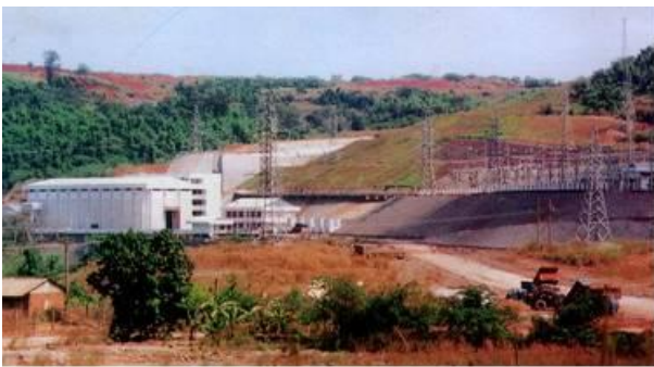
Nhà máy thủy điện Thác Mơ
