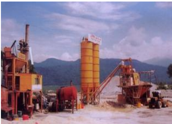
Trạm trộn bê tông nhựa nóng
