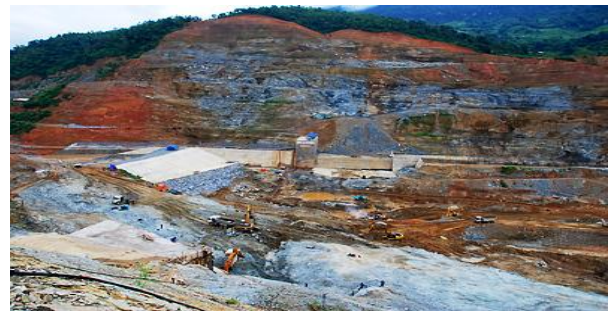
Nhà máy thủy điện Bàn Chát
