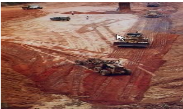
Đập nước nhà máy thủy điện Đa Mi
