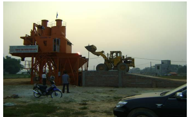
Trạm trộn bê tông thương phẩm
