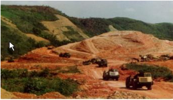
Nhà máy tuyển quặng apatit Lào Cai
